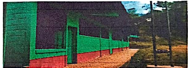
Foto 4: Se observa ventanas, vidrios y puertas en mal estados.
